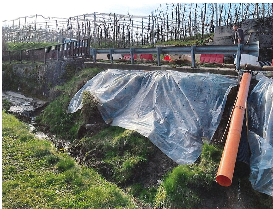
PRIMO INTERVENTO DI MESSA IN SICUREZZA
