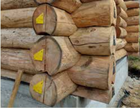
Figura A - Particolare dei giunti d'angolo nella costruzione del ricovero in località “Sette Laghi”, Torcegno. (S. Liberi, Archivio Servizio Foreste PAT)
