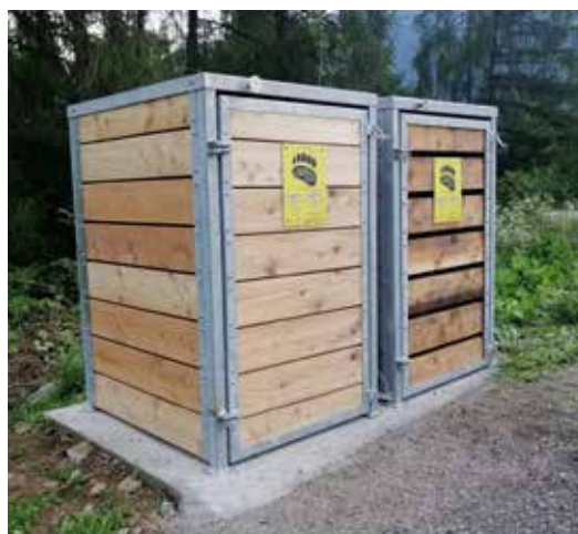
Foto n. 29 - I primi due prototipi di struttura anti-orso dislocati in via preliminare in Val di Sole a protezione di bidoni dell'organico (M. Benvenuti, Archivio Servizio Faunistico PAT)
